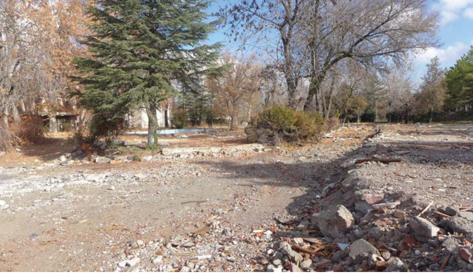
1. AÖÇ'de inşası süren ve Temmuz 2014 tarihine yetiştirileceği söylenen Başbakanlık Hizmet Binası, Mayıs 2014.
